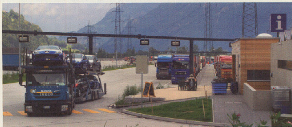
Das SVZ am Nordportal des Gotthard-Straßentunnels als vorgelagerter Warteraum.
